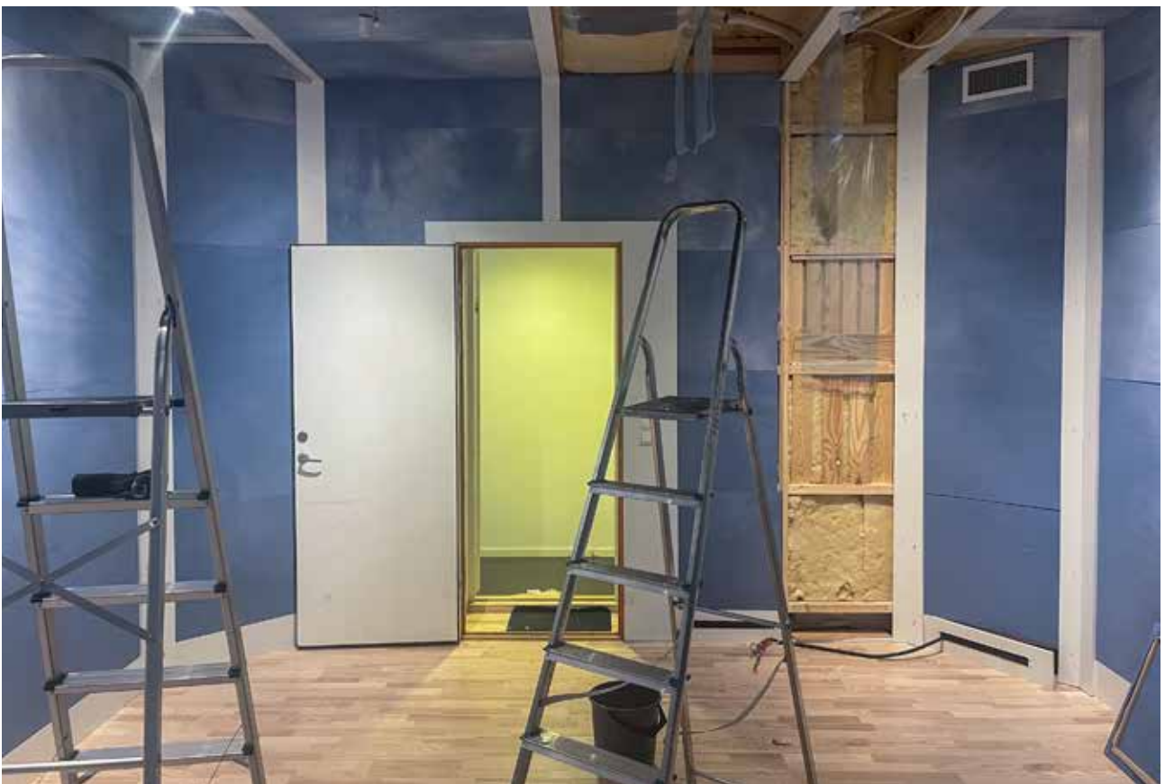
Notams gamle studio 3 under demontering. Foto: Bjørg Tønnessen
