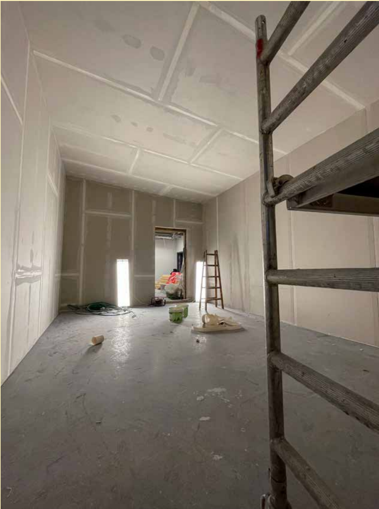
Notams nye studio 1 under konstruksjon. Foto: Bjørg Tønnessen
