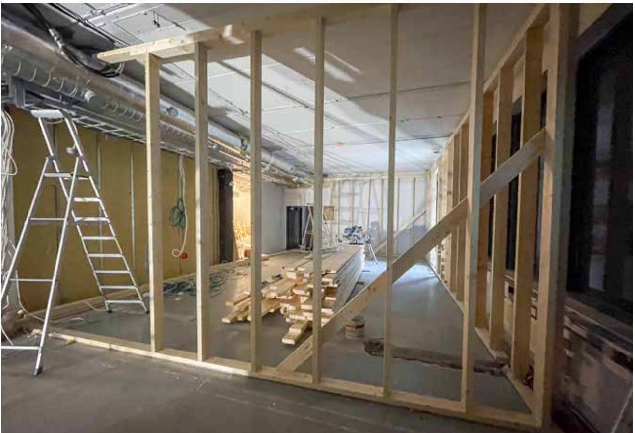
Notams nye prosjektrom før, og under konstruksjon. Foto: Bjørg Tønnessen
