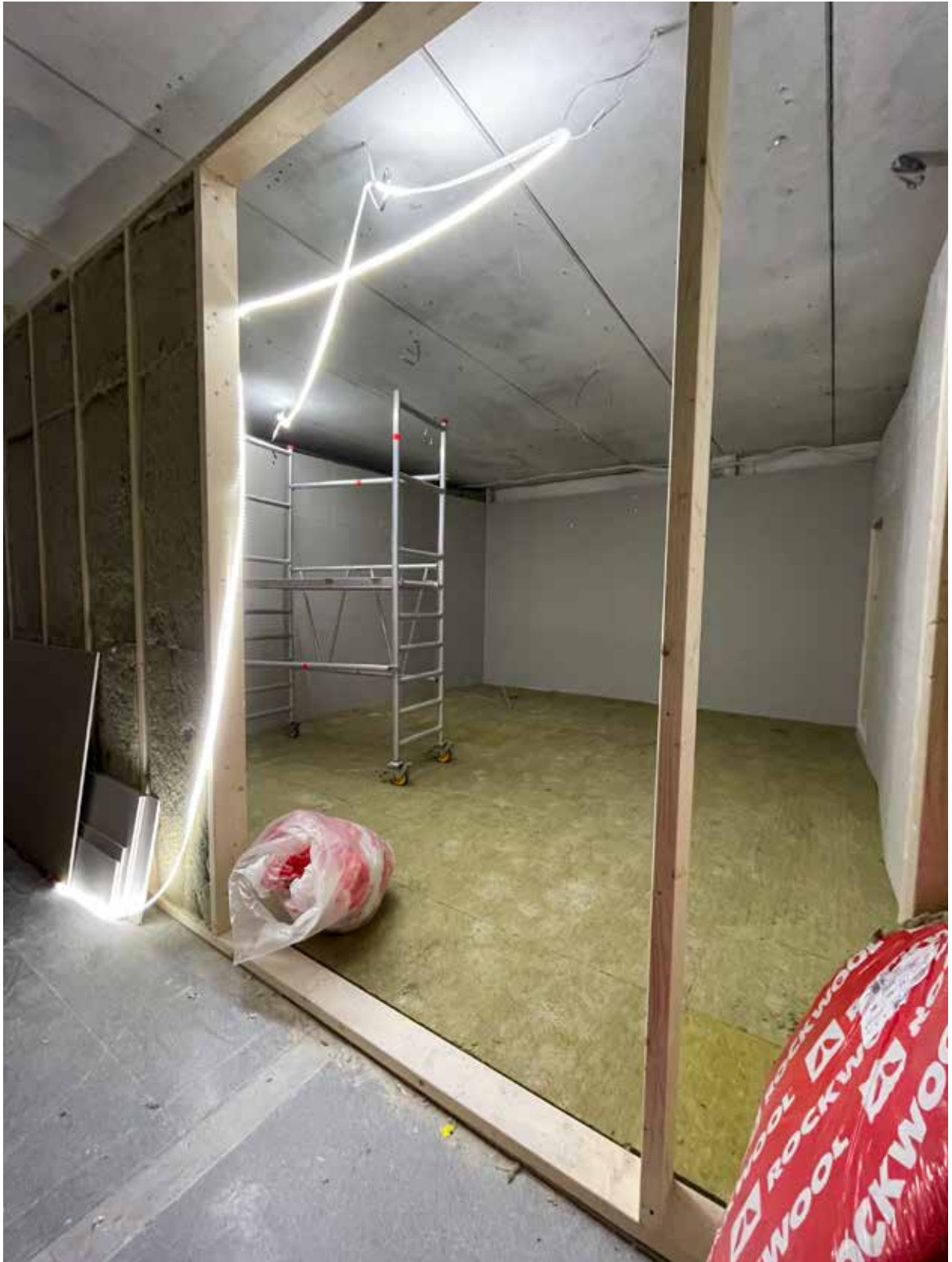
Notams nye studio 3 under konstruksjon. Foto: Bjørg Tønnessen
